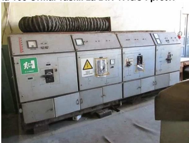
Ad 168 Ormar raskl. za DIN VAGU i pretv.
