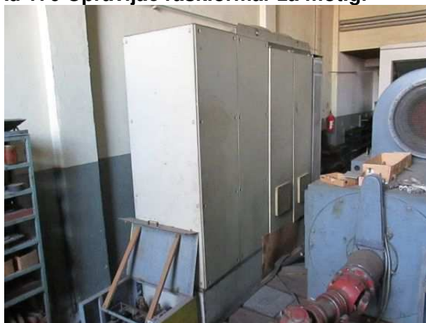
Ad 170 Upravljač rask.ormar za mot.gl
