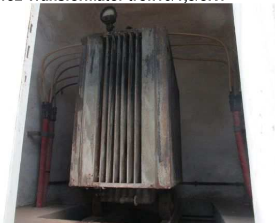
Ad 152 Transformator trof.10/1,5/3KV
